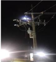
**MANIOBRA PUNTO CALIENTE SECCIONADO RECONECTADOR:** Se requiere realizar la corrección del punto caliente para evitar apagones repentinos, daños en equipos y posibles daos estructurales por corto circuitos.
