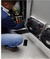
**MANTENIMIENTO SISTEMA AIREACION DE LOS VARIADORES:** Se realiza el mantenimiento del sistema de aireación el cual es el encargado de inyectar aire frio a los variadores y mantenerlos en una temperatura de trabajo óptimo.
